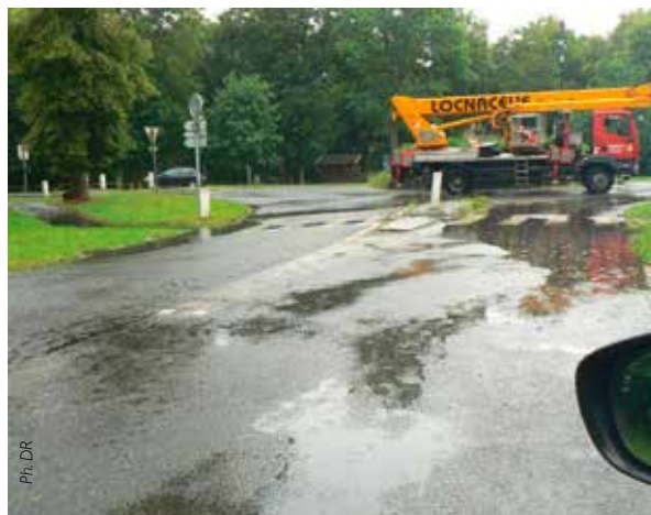
Le rond point Royal, victime du ruissellement des eaux pluviales.
