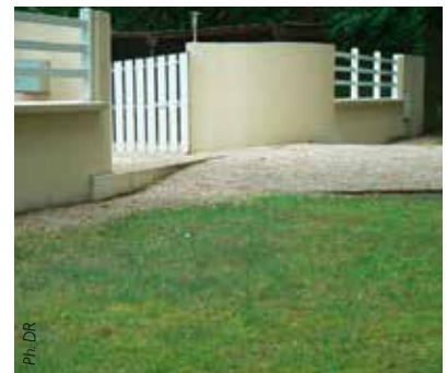
Une entrée réhaussée facilite les écoulements.
